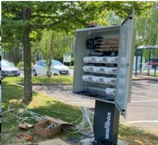
Installation bornes de recharge électrique
