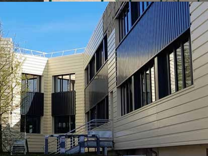
Siège BAUDIN CHATEAUNEUF - Bureaux Sud (45)
