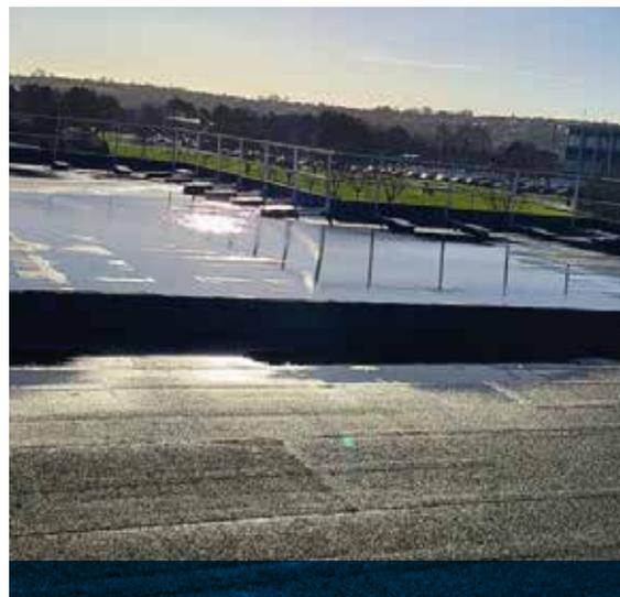
Après la dépose de l'étanchéité et de l'isolation existante, ROSAY a mis en œuvre un nouveau complexe sur le bâtiment Jean Bart de l'USID de Cherbourg.
