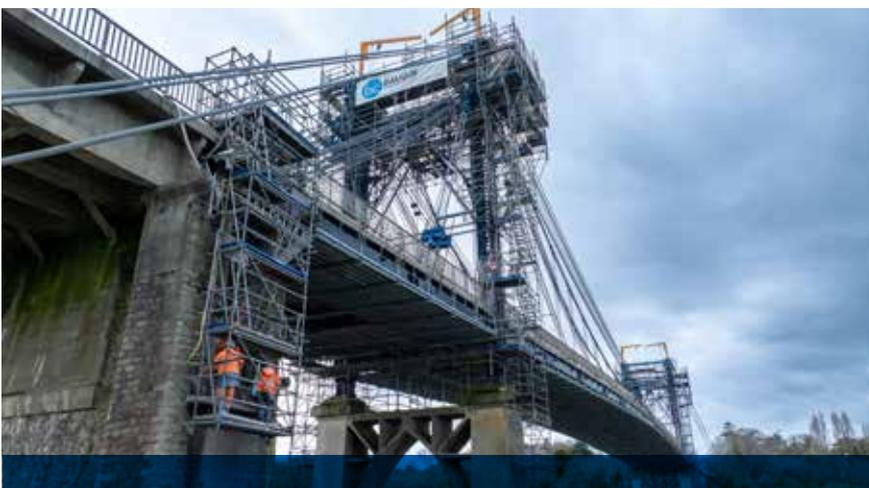
De nombreux travaux restent à accomplir avant la livraison : dépose de suspension provisoire, équilibrage de la nouvelle suspension, remise en peinture des pylônes, démontage des échafaudages ... mais l'équipe reste motivée pour relever ce défi qui se sera étalé sur plus de 3 ans.
